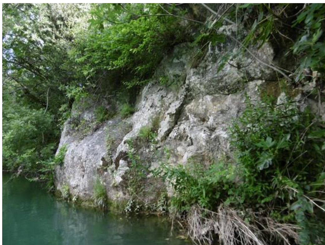
Berge abrupte du tronçon 23 (photo prise le 21/05/21)
